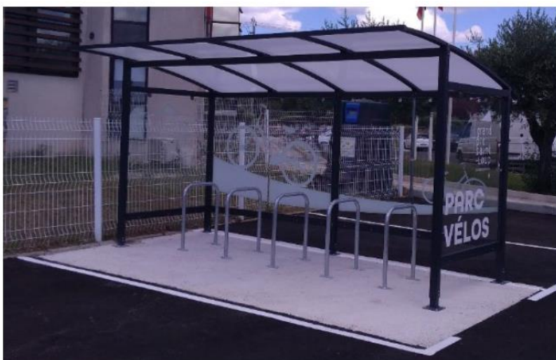
Exemple de 10 emplacements vélos pour visiteurs installés sous un abri – Alvéole +
