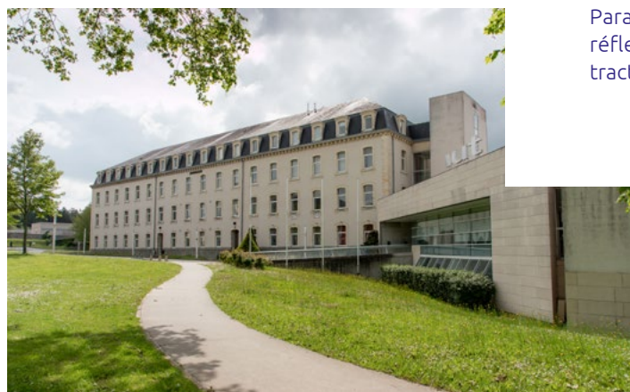
Locaux de l'IUT à Saint-Lô.
