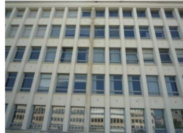
*Façade du bâtiment B avec ses fenêtres à battant d'origine en simple vitrage.*
